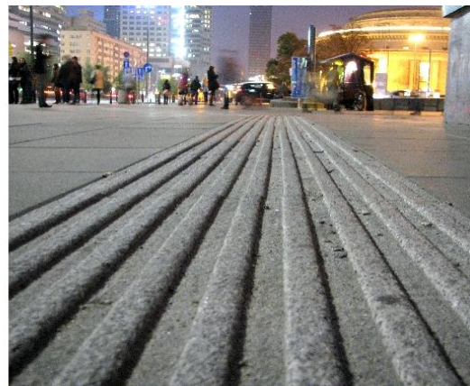
Fig.1 a) Modell eines Elementen „Berührungspfad“ mit Längsvorsprüngen,
